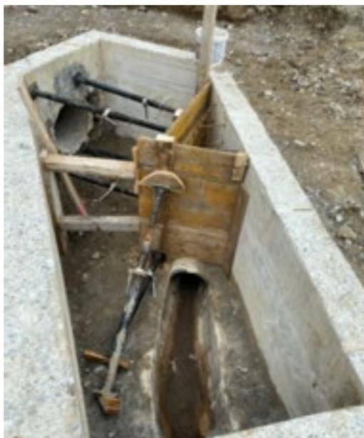
Zur Entlastung der ARA wurden Sauberwasserleitungen erstellt. Oftmals herausfordernd sind im kommunalen Werkleitungsbau die engen Platzverhältnisse und die bereits vorhandenen Leitungen, welche auch während der Bauarbeiten in Betrieb sind.
